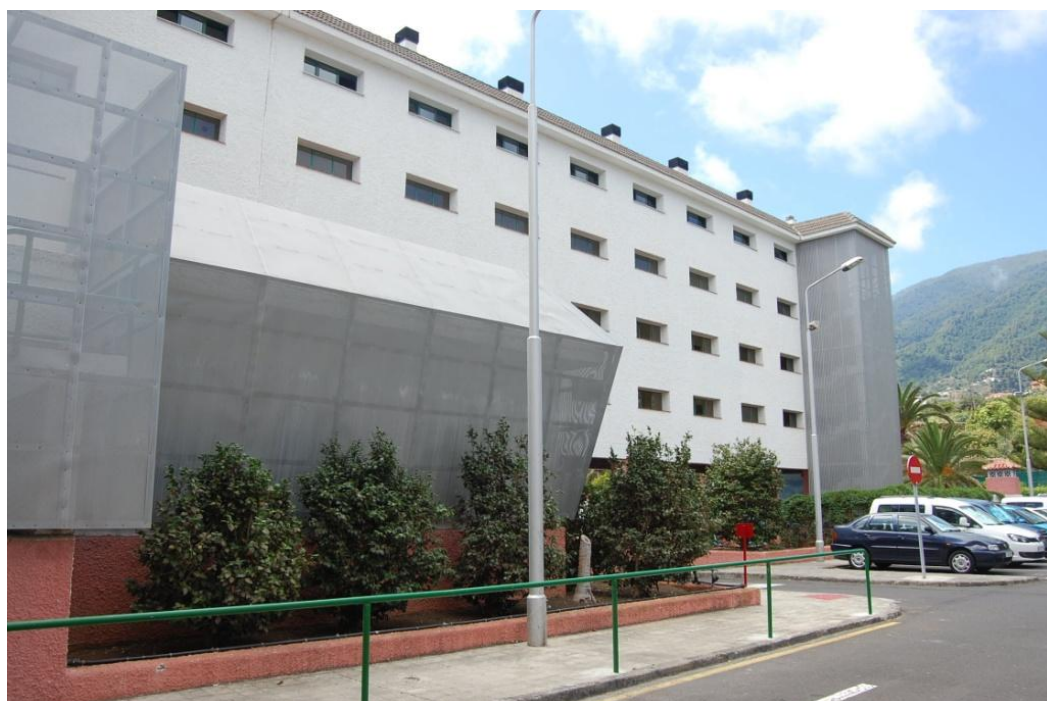
Ilustración 10: Vista exterior del edificio
