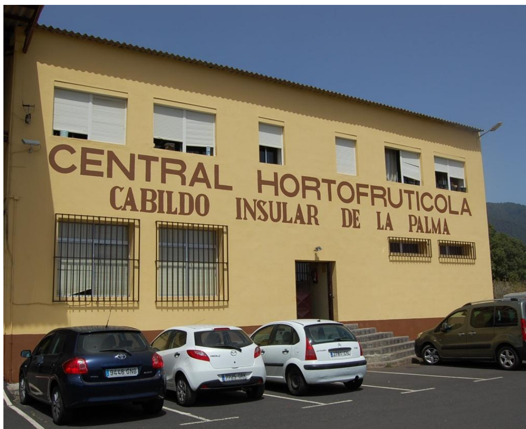
Ilustración 10: Vista exterior del edificio
