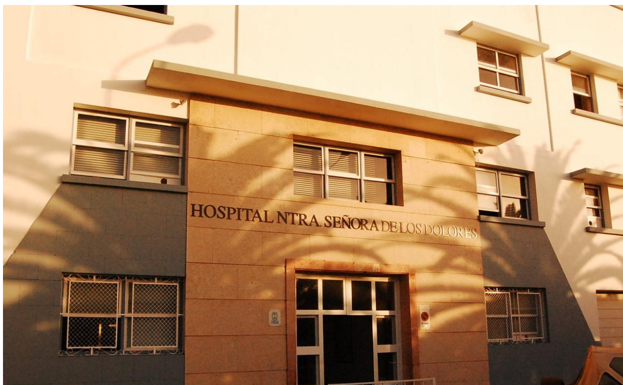
Ilustración 10: Vista exterior del edificio
