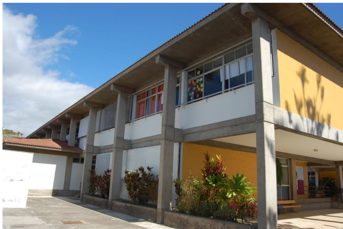
Ilustración 10: Vista exterior del edificio
