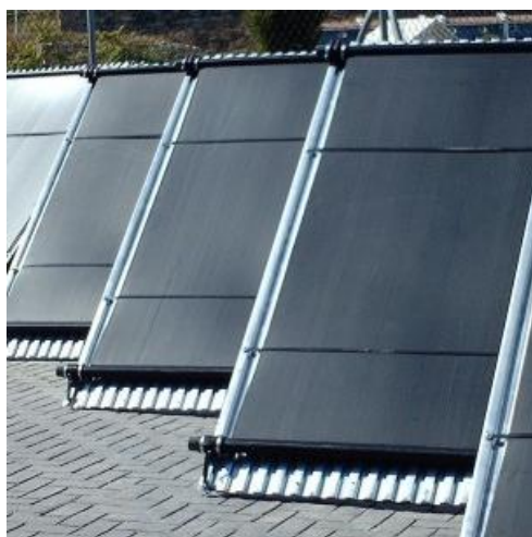
Ilustración 6. Colectores de polipropileno
