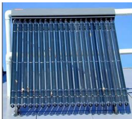
Ilustración 5. Colectores de tubos de vacío
