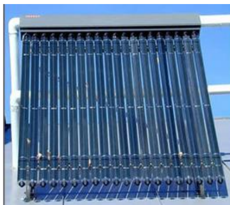
Ilustración 5. Colectores de tubos de vacío
