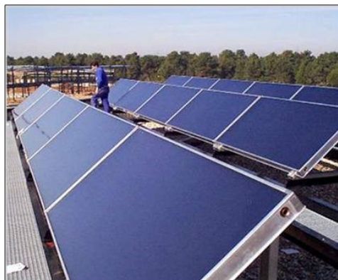
Ilustración 4. Colectores vidriados planos
