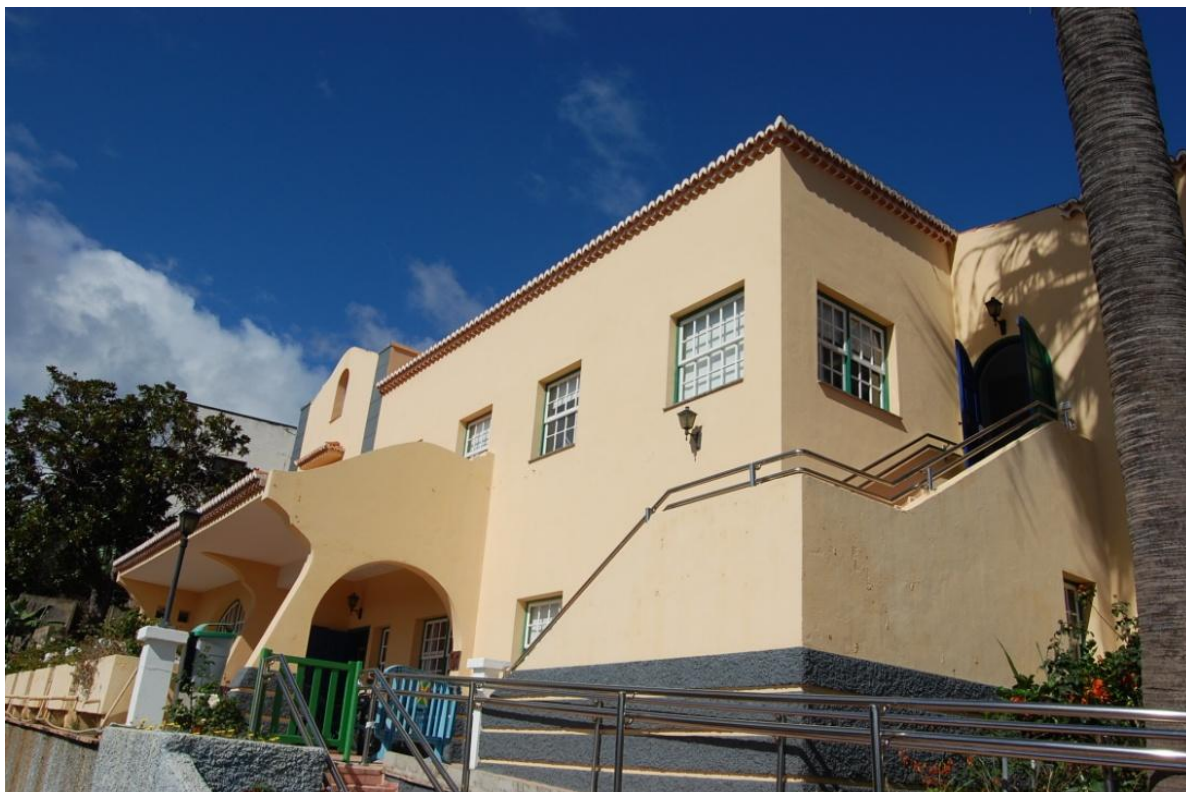
Ilustración 10: Vista exterior del edificio
