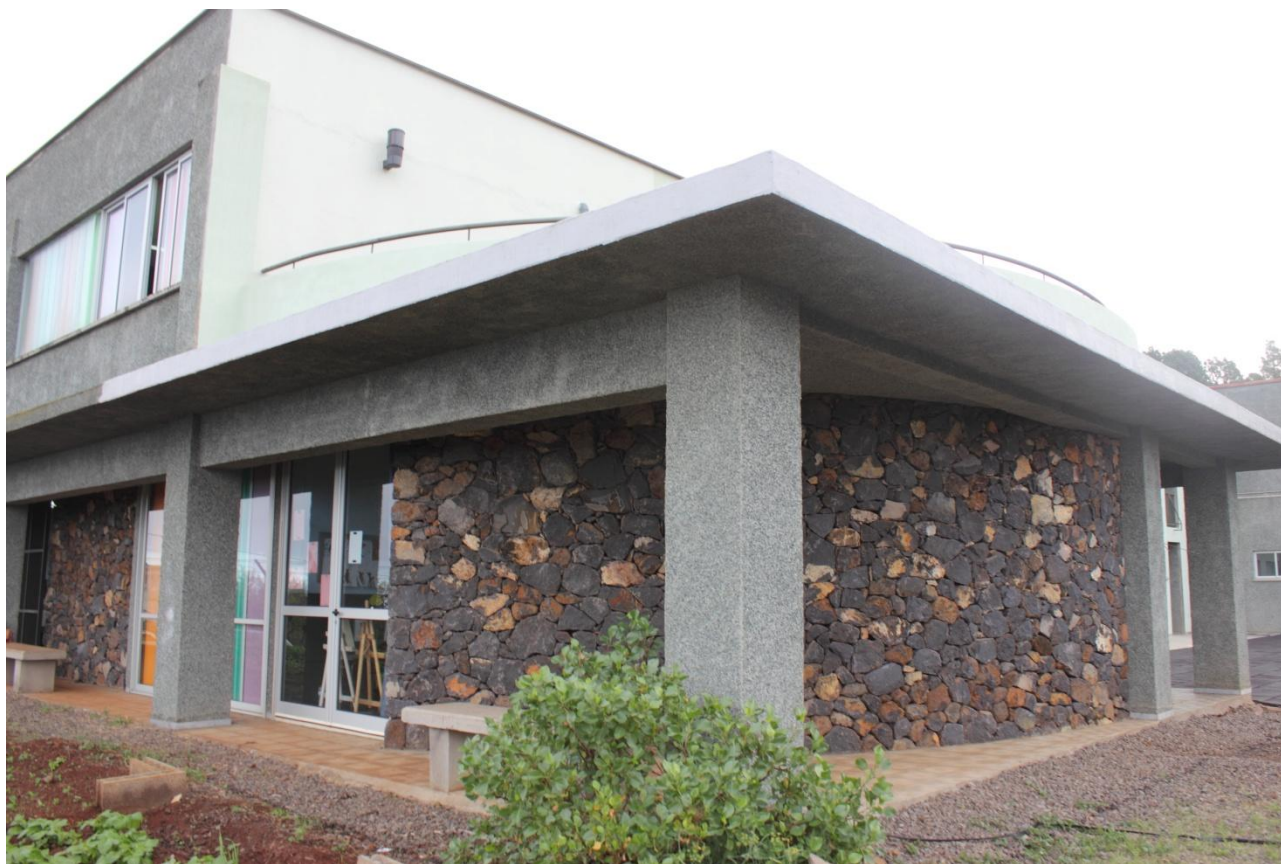
Ilustración 10: Vista exterior del edificio
