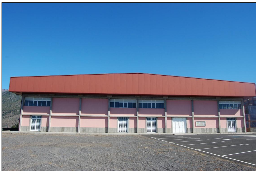
Ilustración 10: Vista exterior del edificio
